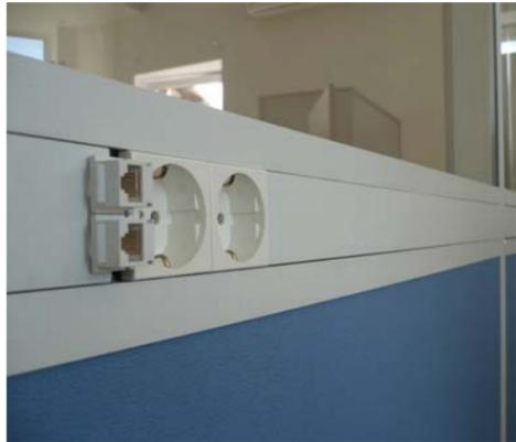
Каждому из типоразмеров короба соответствует набор аксессуаров, обеспечивающих конструктивную и эстетическую завершенность: это могут быть манжеты и стыки для соединения прямолинейных элементов, углы внутренний и внешний для соединения в углах и отводы для ответвления кабельной трассы на 90°, оконцеватели для защиты изоляции на выходе из канала и торцевые заглушки.
